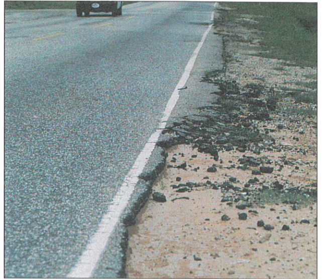
Edge Failure
